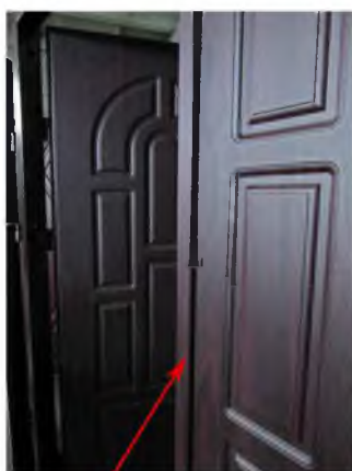
ШИРИНА ПРИТВОРНОЙ ПЛАНКИ 40 мм
