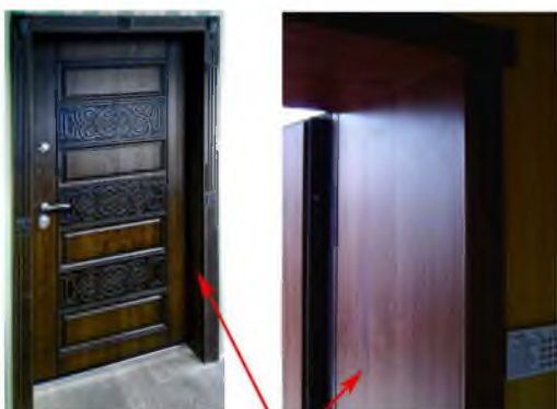
обшивка проема внутри
