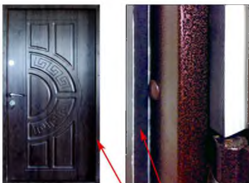
термомост 26 (38) мм
